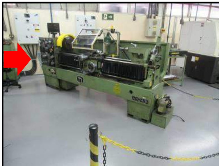
Condutores de Alimentação
